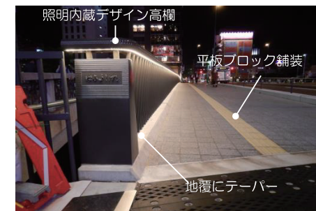
橋面の状況(高欄・地覆・舗装)
