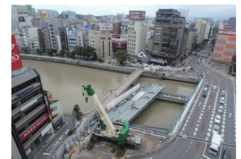
本線上部工架設状況
